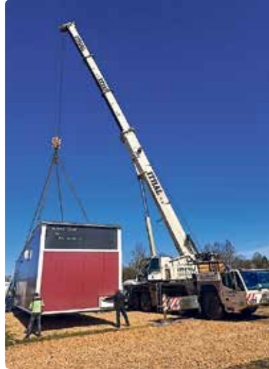
Pärast kaks tundi kestnud etteval- mistustööd tõstab lthali autokraana treilerilt messi- platsile Kohtla- Järvel toodetud ja sealt Tartusse veetud 34-tonni- se katlamaja. FOTO: PRIIT PULLERITS
